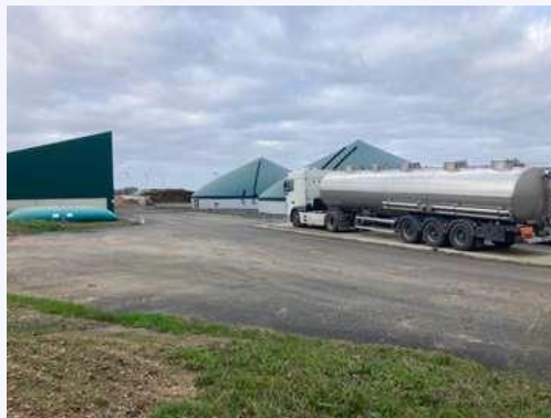
Arrivée de la pulpe sur le site de méthanisation pour la production de biogaz et de fertilisant
